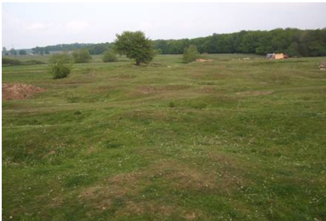
Foto 8. Aspect general al terenului după închiderea mai multor puțuri.
