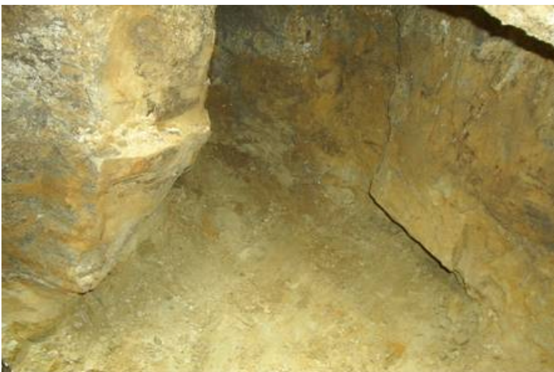
Foto 2. Imagine a nivelului gresiei de Burdujeni care este urmărit pentru valorificare.
